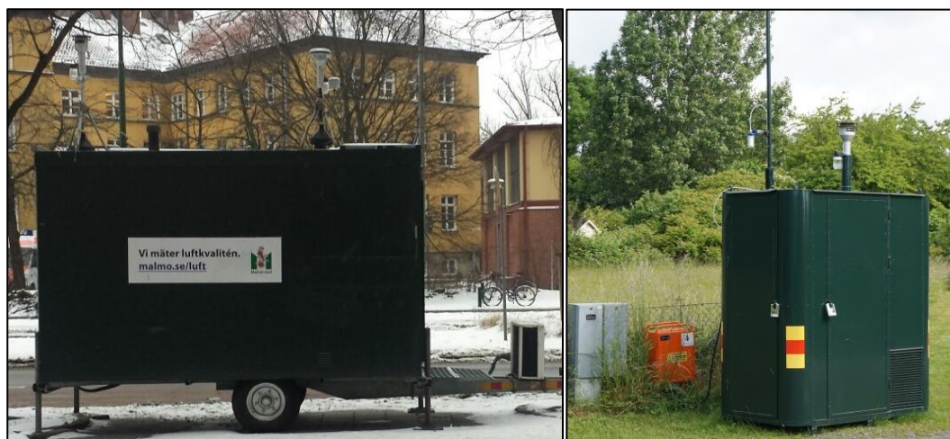
Figur 6. De två portabla mätvagnar MV4 och MVx som används för temporär mätning inom Skåne.
